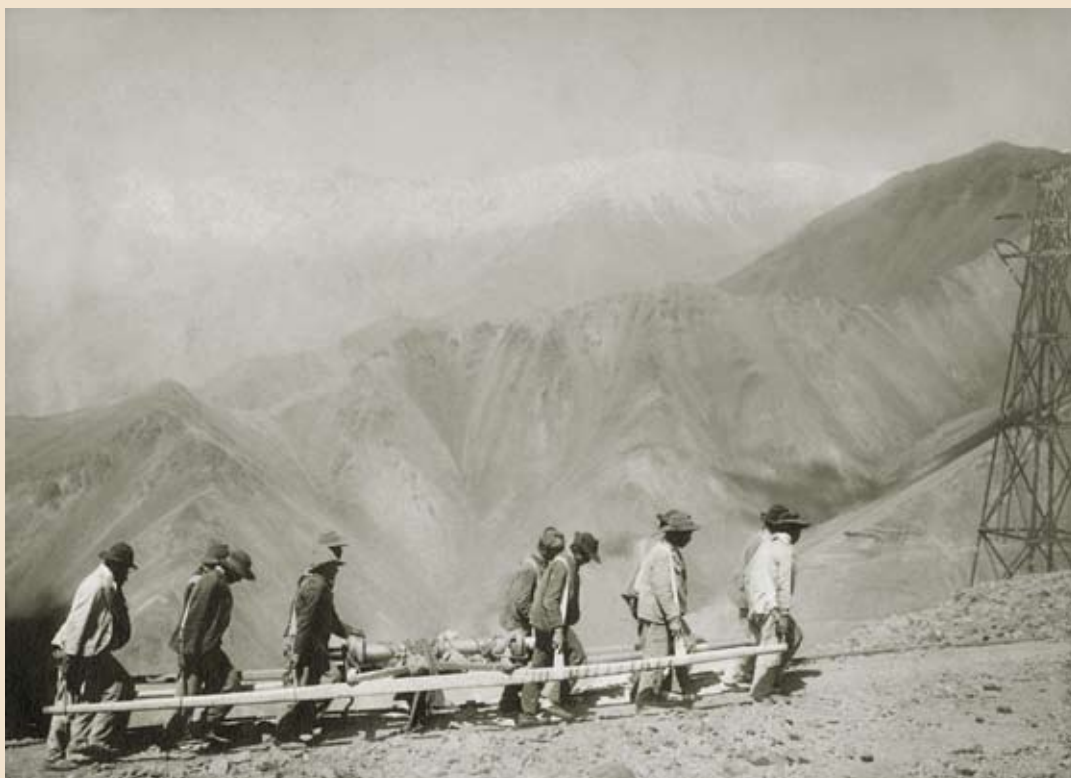
1. Transporte desde el fin del séptimo tramo de la obra, a 3900m de altitud, del eje del motor de la estación final del octavo tramo, el penúltimo, a 4400m de altitud.
